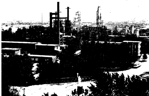
常减压蒸馏装置
