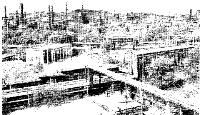
厦门炼油厂生产区一角
