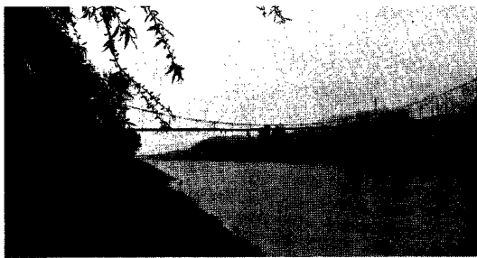
输油管线跨越工程
