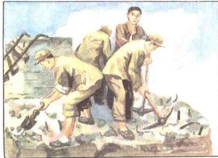
22 紧接着是抢修被敌人炸坏的71号桥。有一个桥墩被炸得剩下半截，需要把墩顶铲平，才能重新打混凝土架梁。几个人挤在小小的墩顶上用镐头刨，施展不开，进度太慢。
