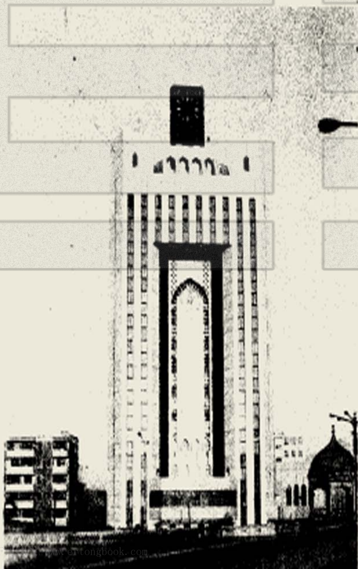
自治区建设银行办公楼
