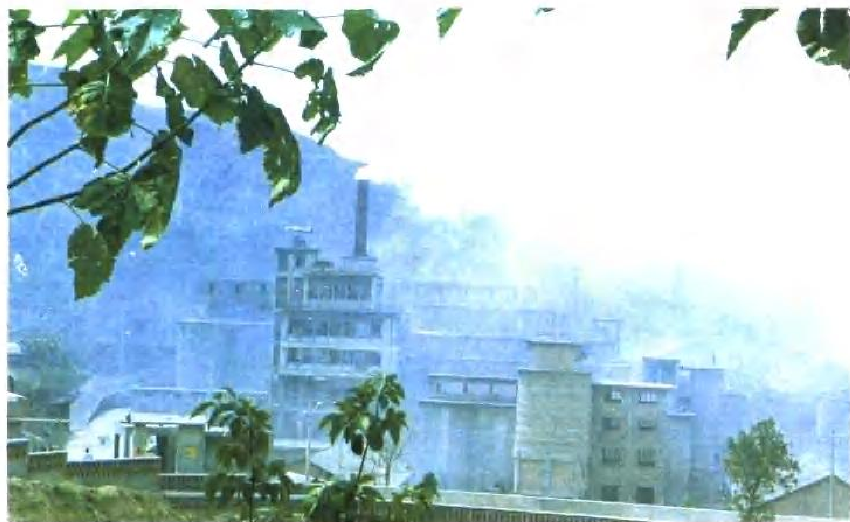
合阳水泥厂一角
