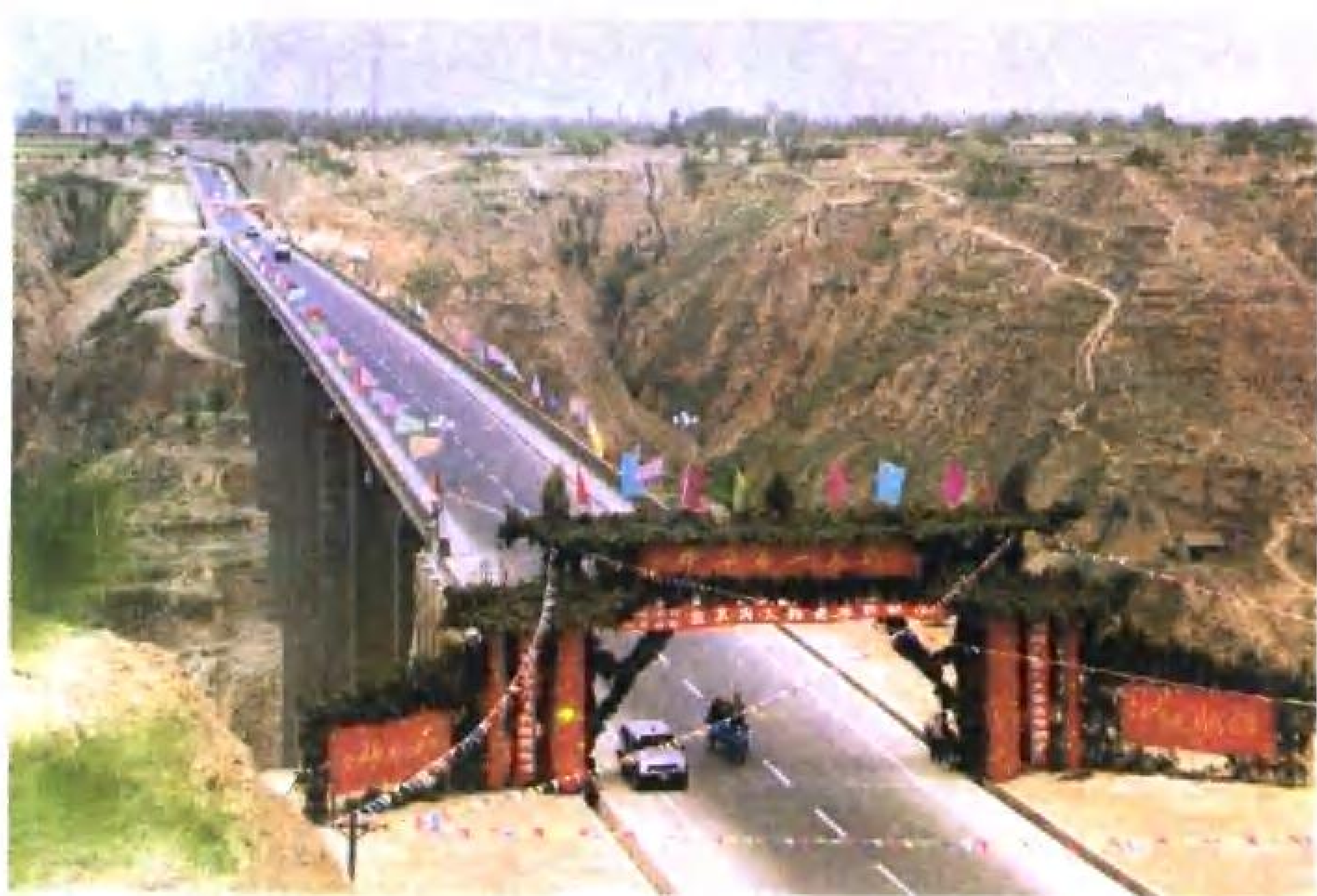
“天堑变通途” 中华第一高桥——108国道合阳金水沟大桥
