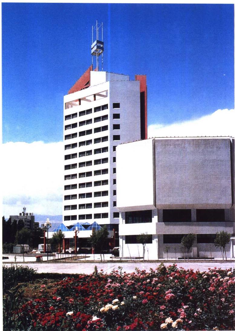
(25) 塔里木石油勘探开发指挥部在“两新两高”的石油会战新体制中，建立的科研与技术监督检测中心大楼。
