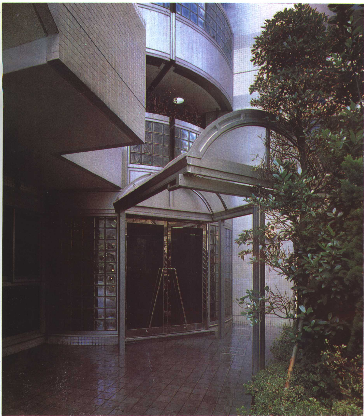
用拱型的玻璃顶棚作为入口的雨蓬,既透光, 又防雨,亦颇具装饰性。
