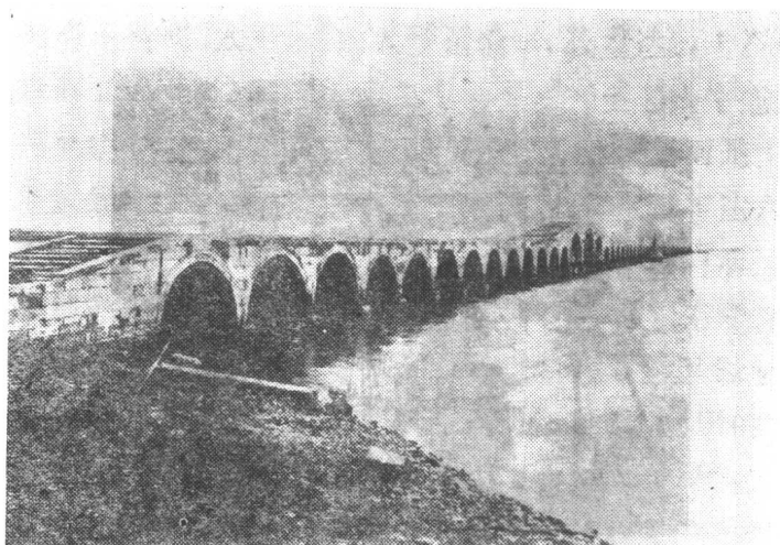
我国现存桥孔最多、桥墩最薄的石拱桥苏州宝带桥
