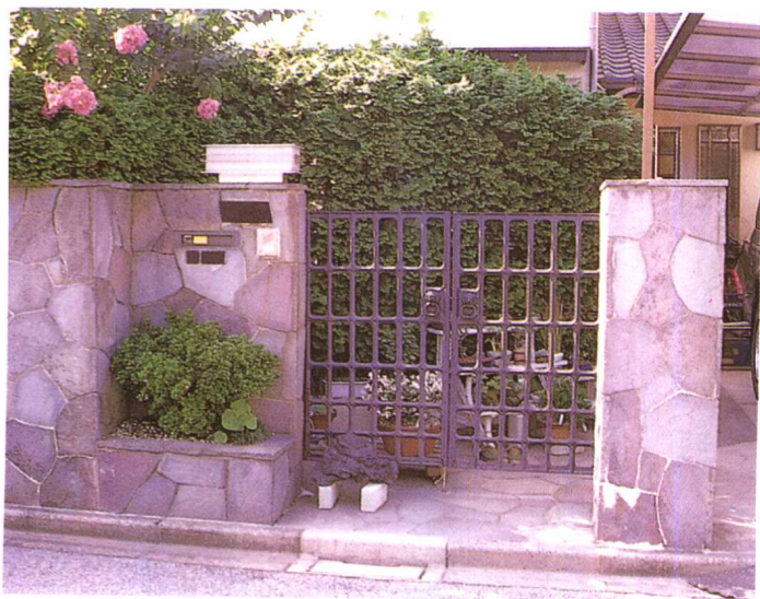
利用片石进行自然组合的侧墙，其表面处理与周围的栽植，增加了整体的谐调性，并与网格状的大门很相配。
