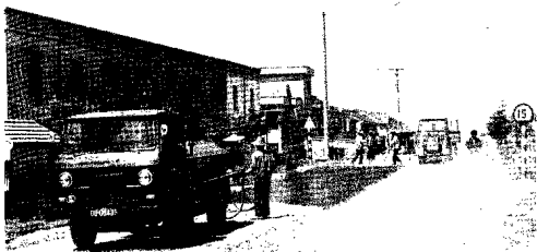
龙东路路面施工
