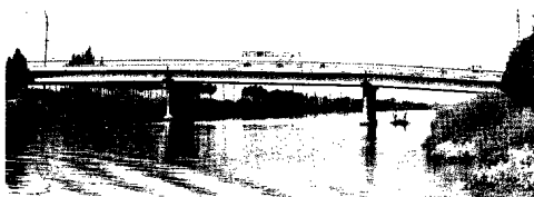
川北路川杨河大桥
