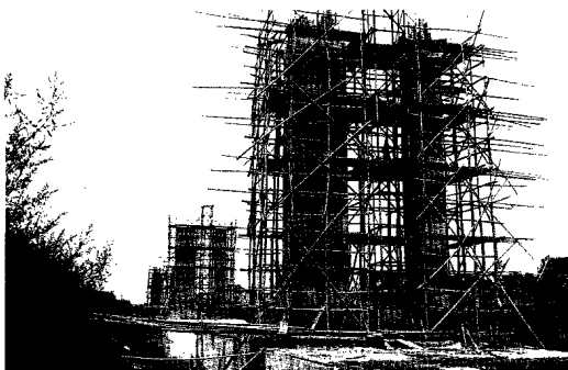
施工中的黄浦江上游引水工程倒虹
