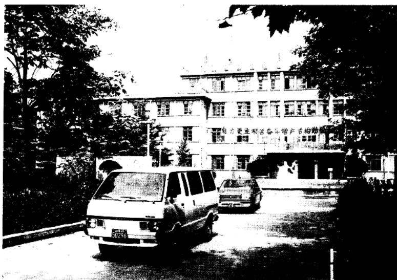
矿机关办公楼
