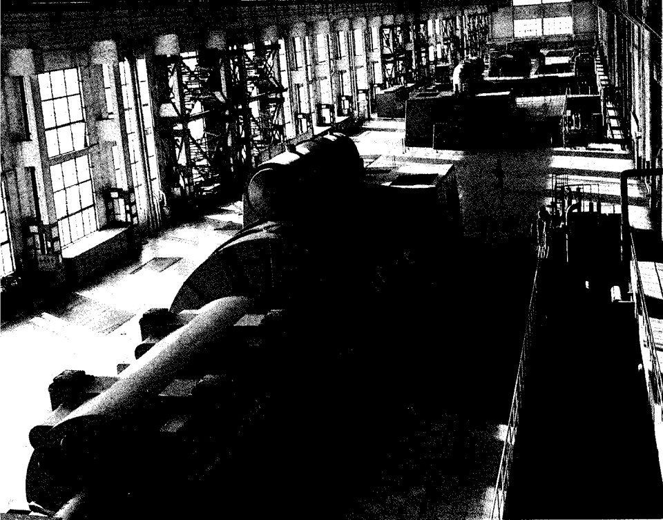
陡河电厂内景
