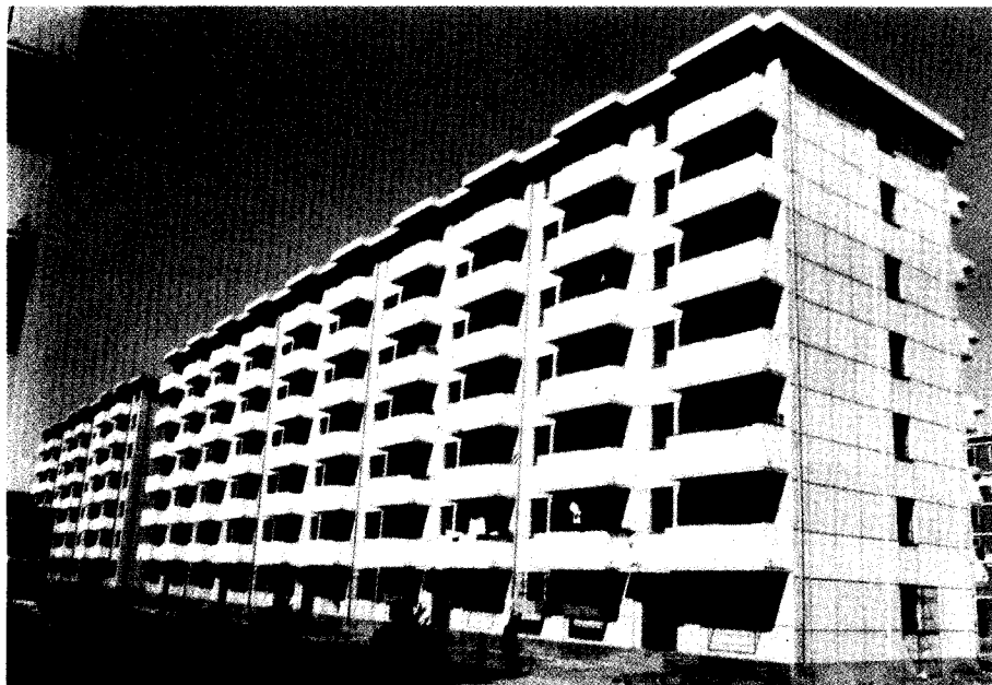
王顶堤住宅楼（红桥区房建承建）
