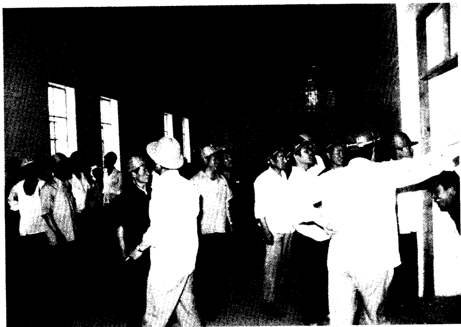
河东区房建公司领导与技术人员一起检查内檐装修质量
