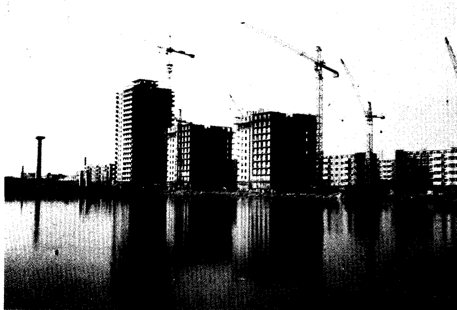
正在开发建设中的水上村住宅区（房产信托公司）
