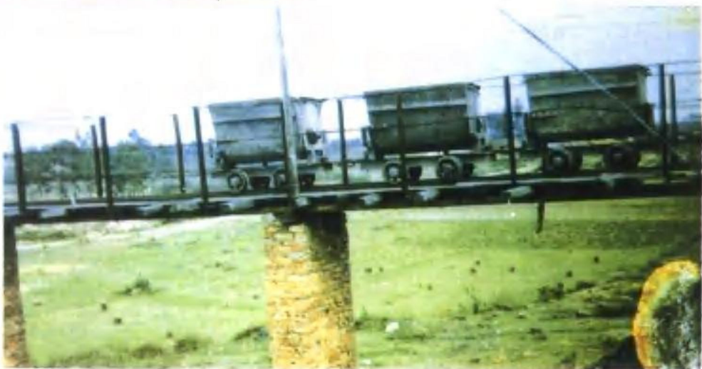
长昌煤矿瓦窑二号井口至煤场运矿车轨道
