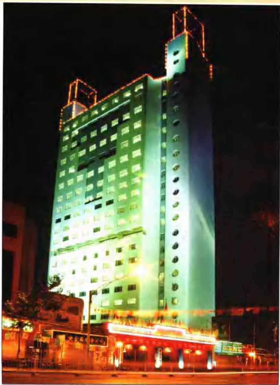
1995年建成的南京供电局生产调度楼
