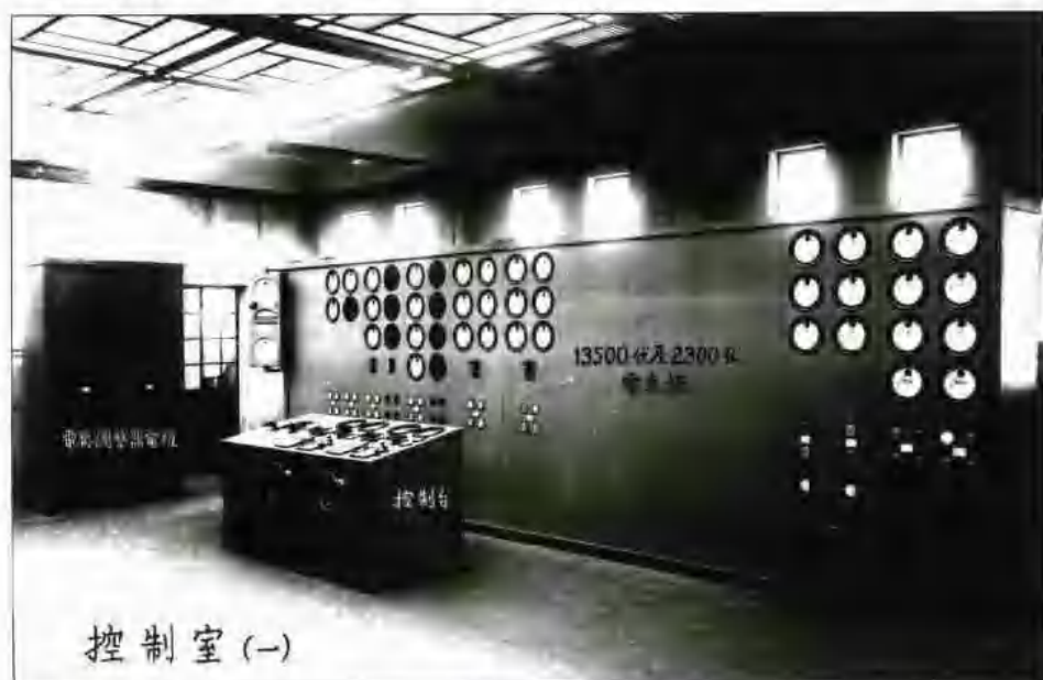
首都电厂下关发电所控制室
