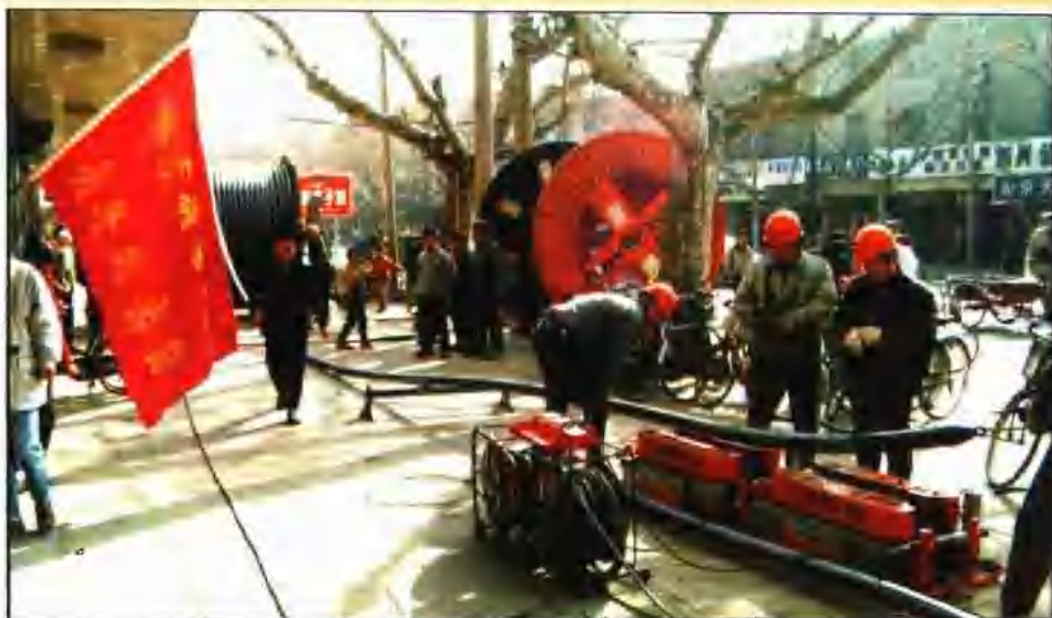
1996年1月,施工人员施放110千伏珠江变电站电缆
