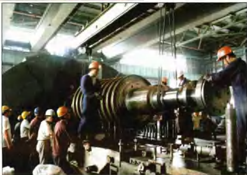
华能南京电厂汽轮机检修现场
