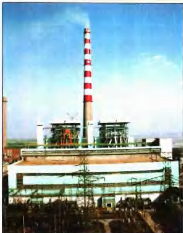
华能南京电厂主厂房
