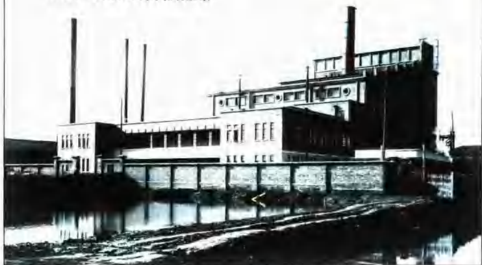
1936 年，首都电厂下关发电所 1 万千瓦发电机组新厂全景
