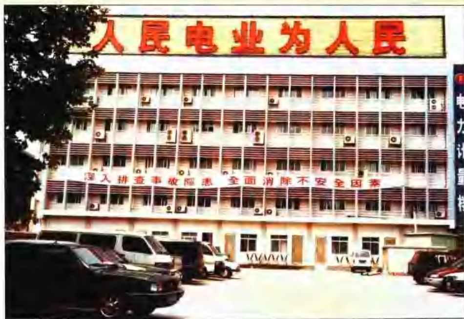
南京供电局电力计量楼
