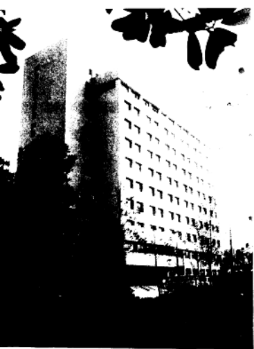
▼ 江苏省卫生防疫站实验大楼 (黄明豪 摄)
