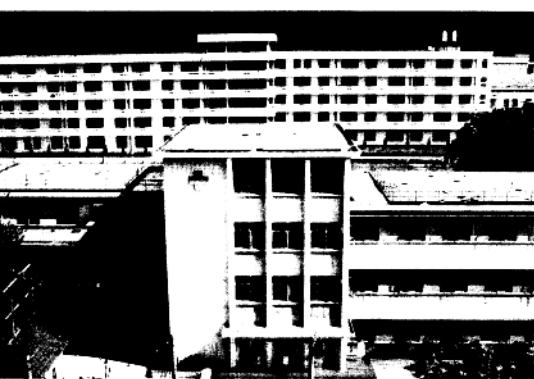
南京海军医院门诊 病区大楼
