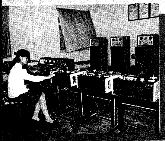
郊区广播站机房
