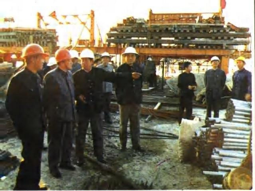
一九八四年八月交通部钱永昌部长(左二)视察哈尔滨市松花江公路大桥工地
