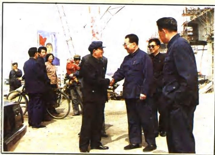
一九八五年春省顾问委员会主任陈雷(前排右二)视察哈尔滨市松花江公路大桥工地
