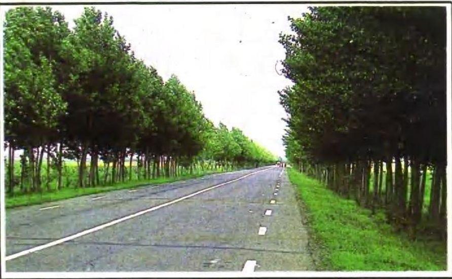
哈同公路的哈尔滨市——宾安段二级公路
