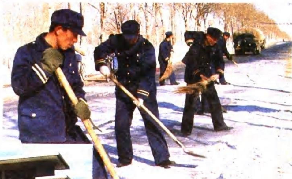
二台子养路工区工人清除路面积雪
