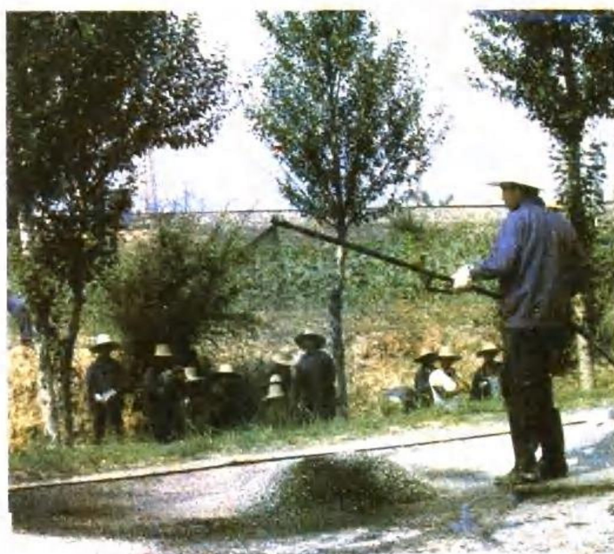
沥青撒布机喷油试验
