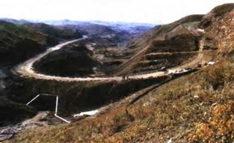
张家口至宝昌公路坝头改线施工
