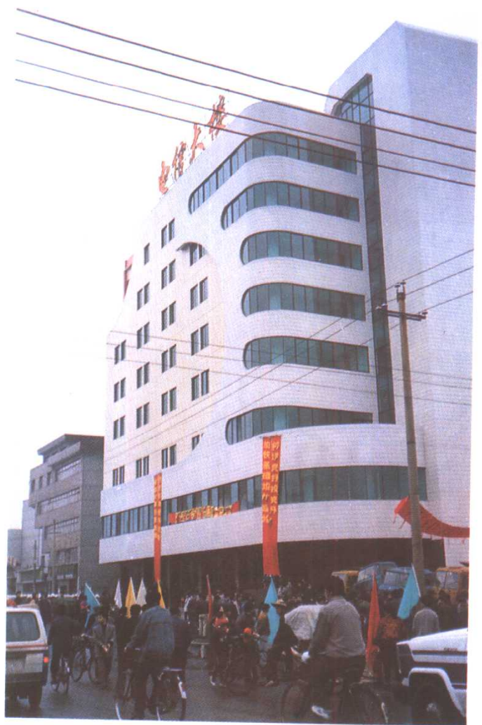
贵阳经济开发区 5000 门程控电话开通
