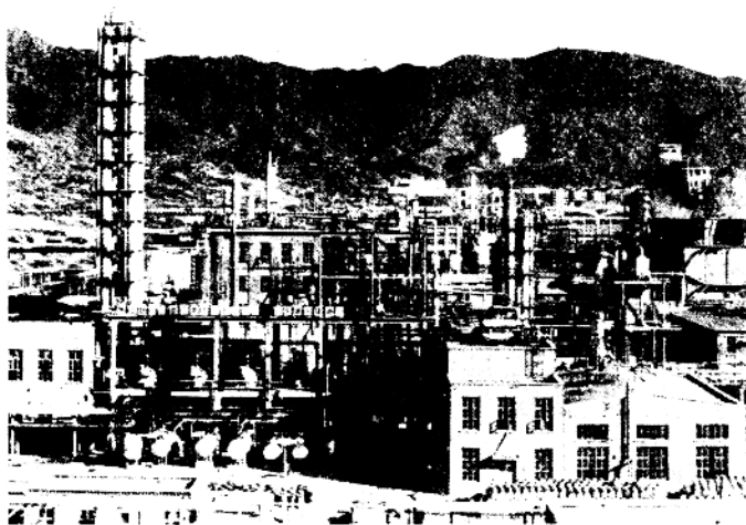
北京石油化工总厂向阳化工厂5000吨/年聚丙烯生产装置
