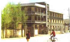
甘南州畜牧兽医服务中心大楼。
