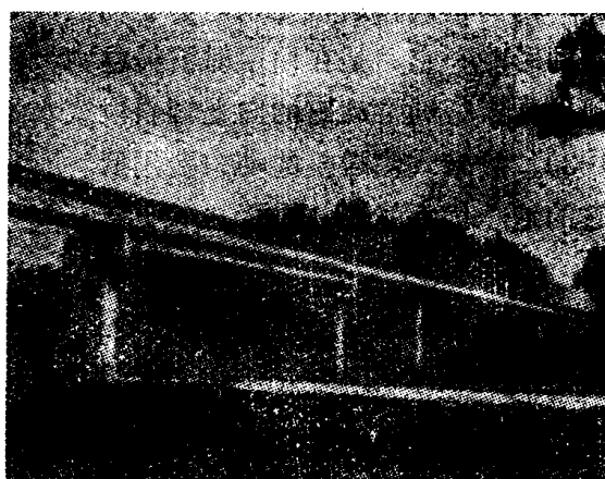
图1-20 采用混凝土支架结构的地面输送机系统具有与地貌相协调的外观
