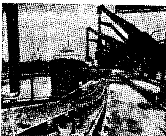
图1-15 轨道式卸船机向钢铁公司的 60 英寸输送机系统供料
