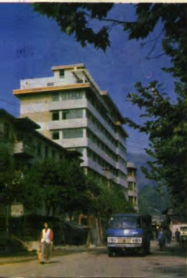
州、市银行大楼
