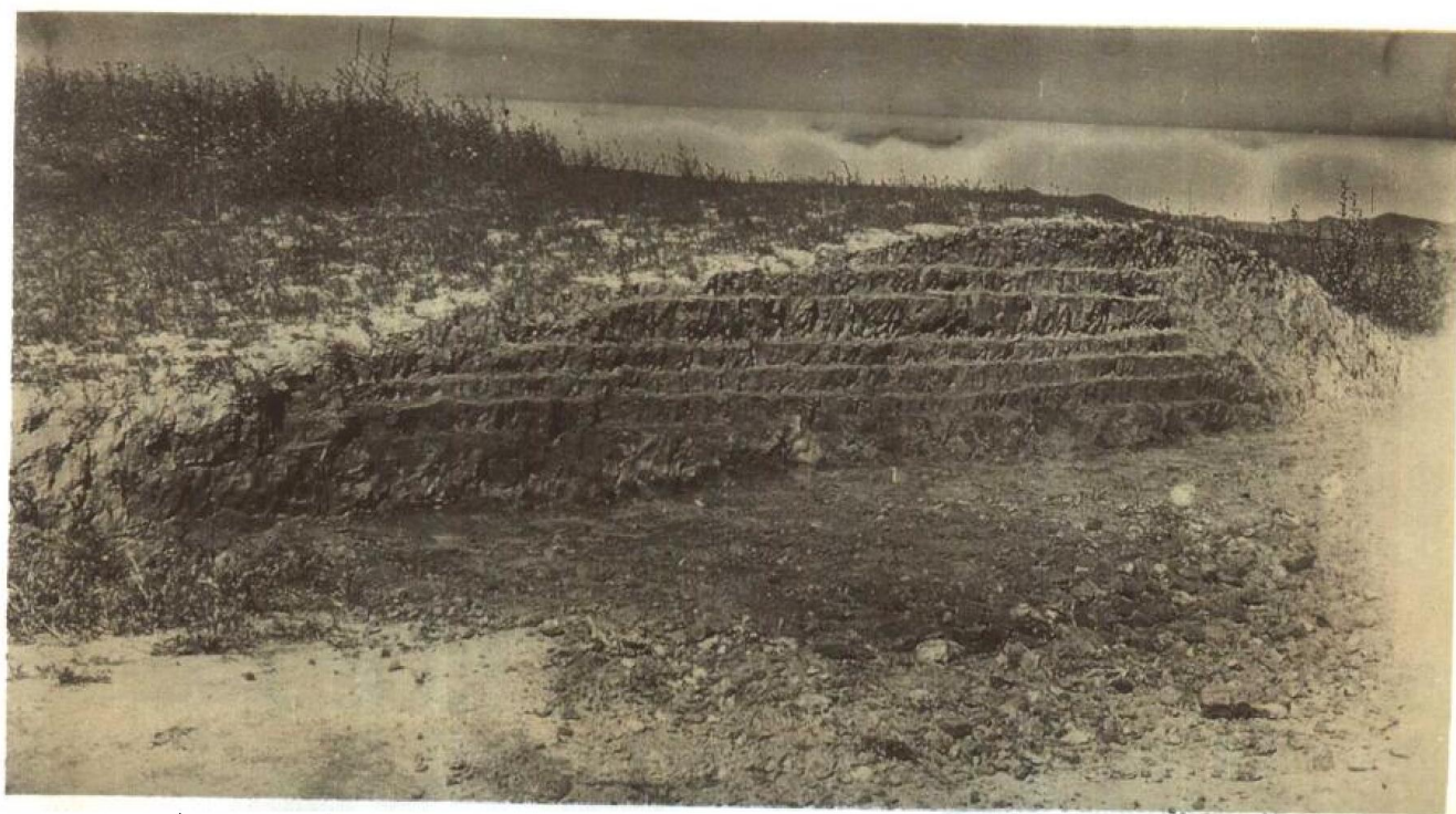
建平县小五家土城夯土墙，夯层厚度为12—26厘米。 项春松摄影
