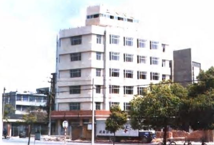
座落在望京路上的宁波工人大厦，现为宁波市总工会办公大楼
