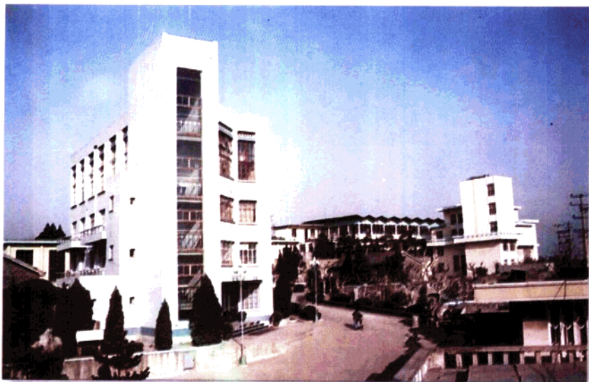
滁州市第一水厂全貌
