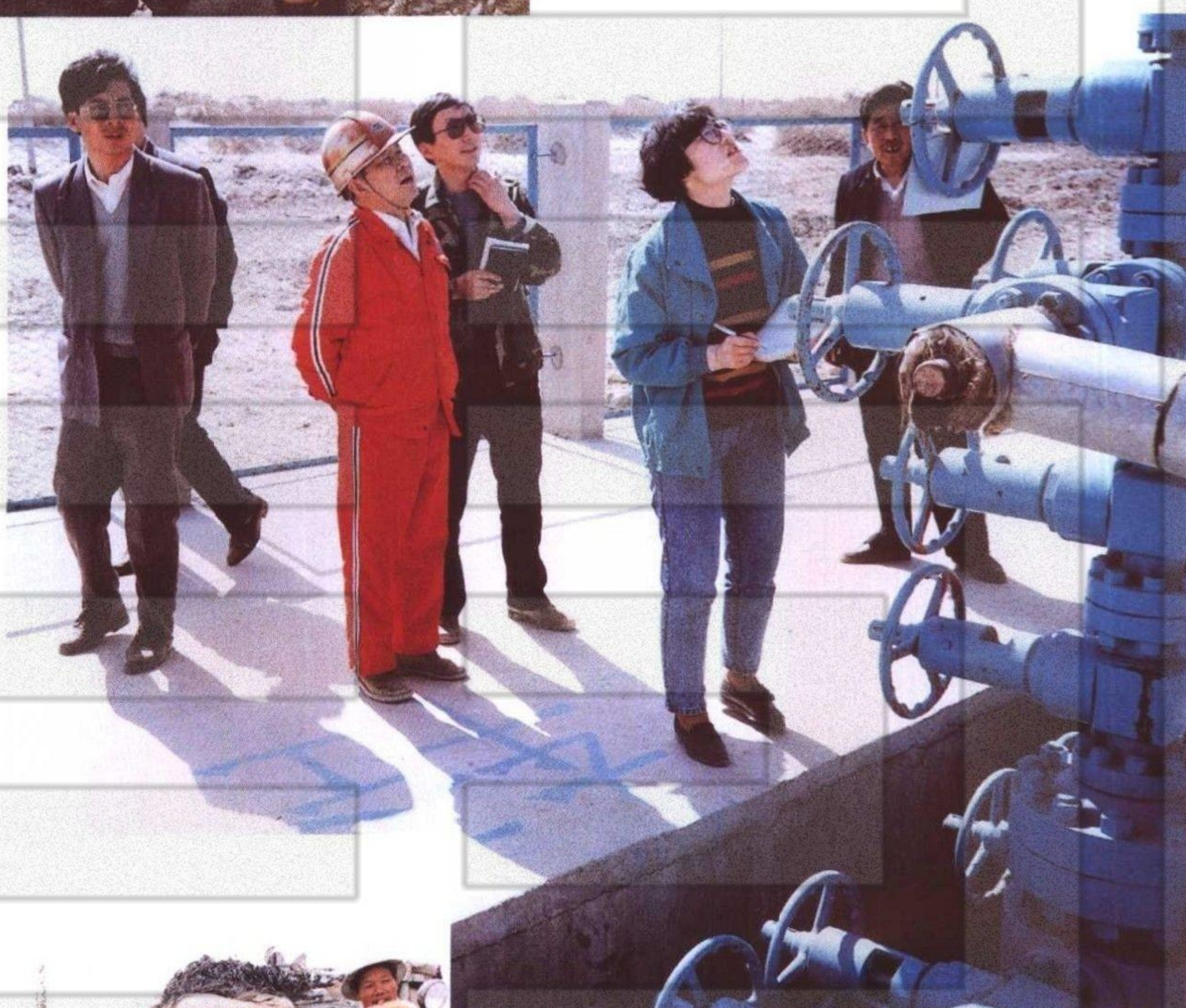
对油气井安全生产进行检查
