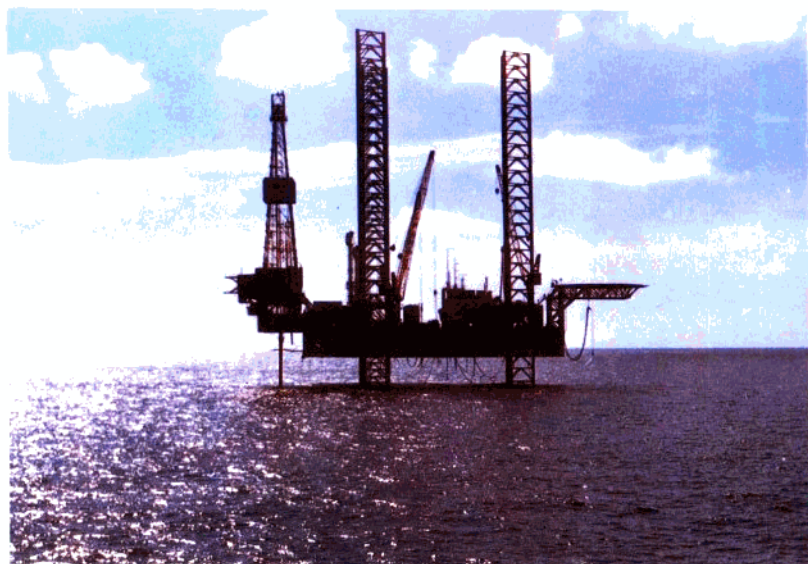
由中国工商银行贷款支持的渤海四号钻井船正在打井。
