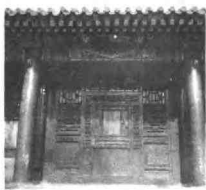
和珅宅中有夹壁墙之房 (今葆光室)
