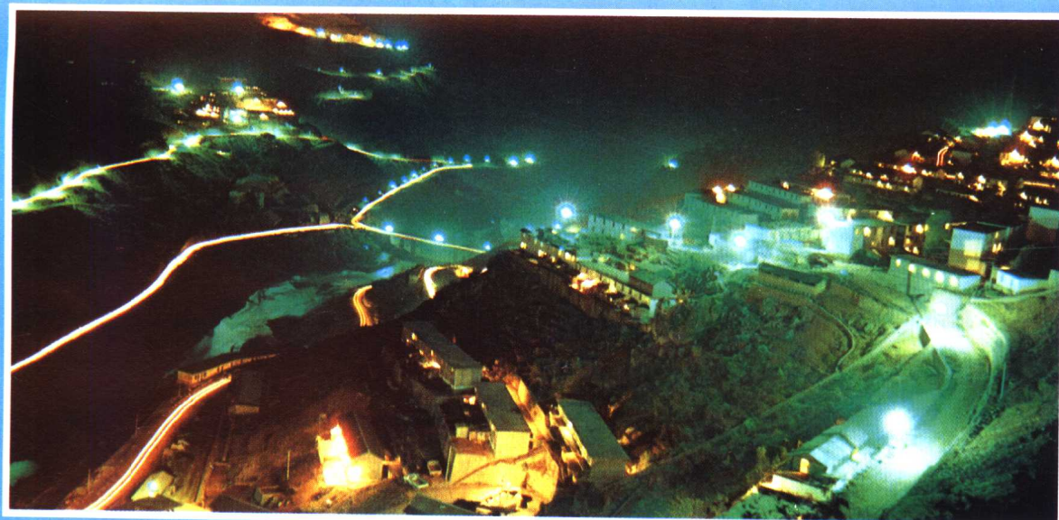
施工中的鲁布格电站夜景。 王正雄摄
