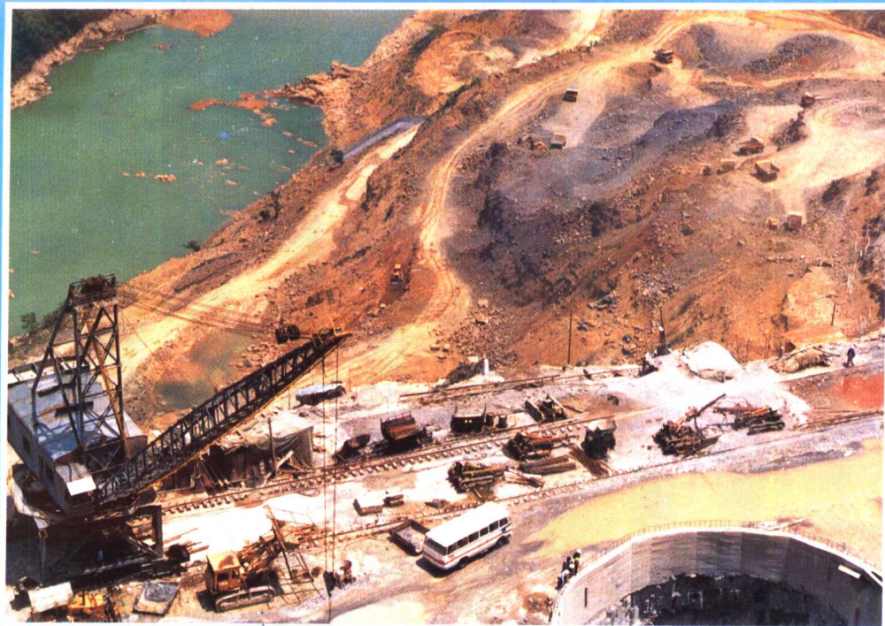
建设中的天生 桥电站。图为1987 年正在开挖的主厂 房基础。
