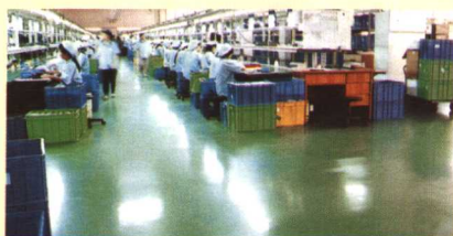
SP-06 自流平水泥砂浆涂装地坪
