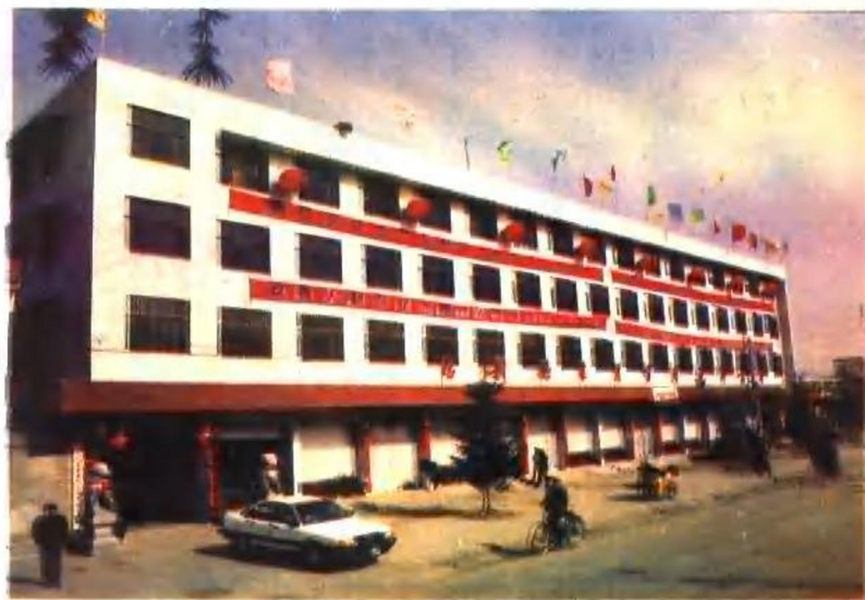
县农资公司办公大楼
