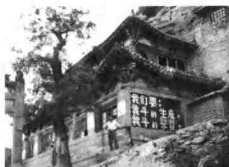
在延安清凉山的中央印刷厂里，有许多上海去的工人。这是该厂机器工房。
