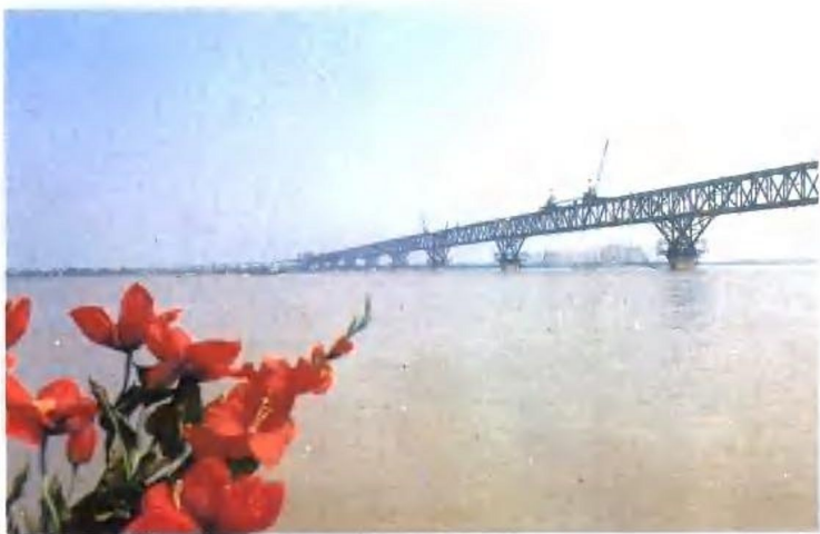
最大的长江大桥——九江长江 大桥正在建设中 刘礼国 摄
