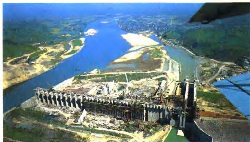
国家重点建设工程万安水电站，装机容量55万千瓦
