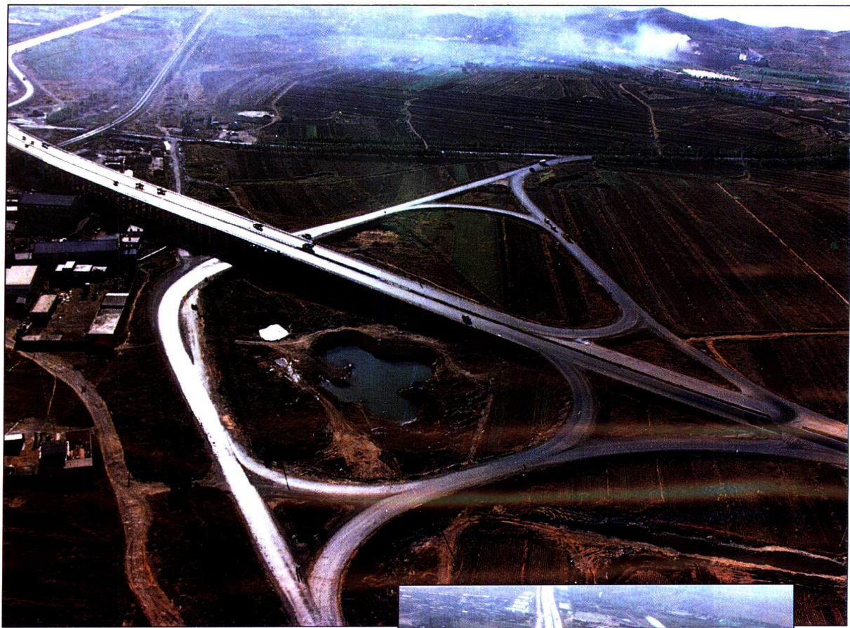
■ 沈（阳）大（连）高速公路后盐互通式立交桥
