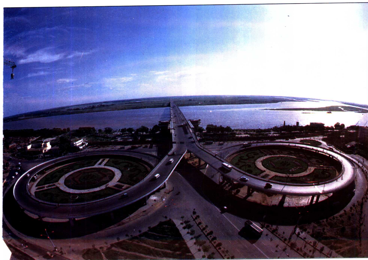
■哈尔滨松花江大桥，全长 1656 米，主桥宽 24 米，是我国目前最宽的公路桥
