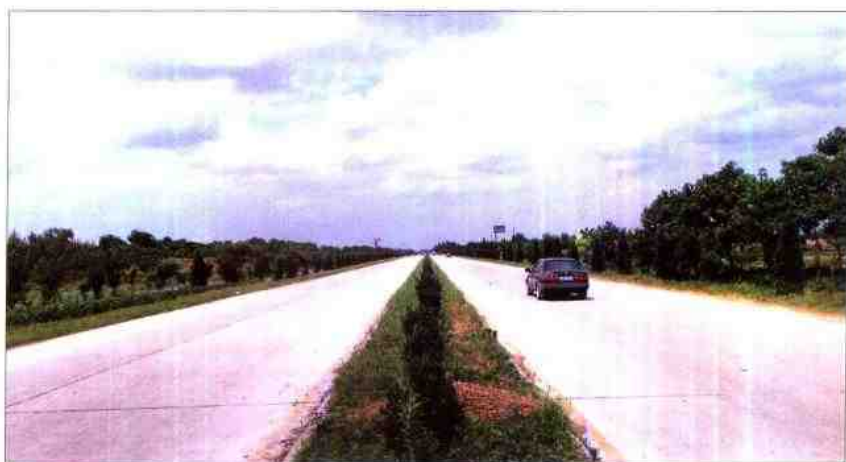
县境内一级钢筋混凝土路面公路
