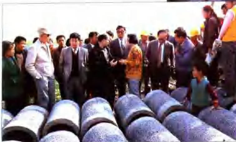
世界银行官员视察杨柳井灌施工现场
