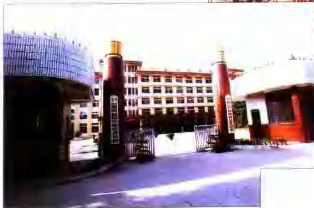
中共濉溪县委办公楼
