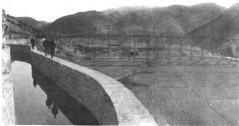
群库汇流总干渠
