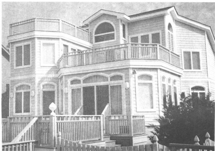
▼图 23 这是位于泽西海边的格里·卡帕诺房屋的后部。它通向海边停泊处，那儿系着他的一艘小船。
