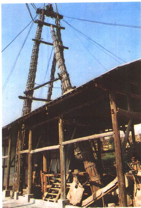
2 四川省自贡市燊海井，世界第一 一口超千米深井。清道光十五年 (1835)以冲击式顿钻法钻成，深 1001.42 米。
