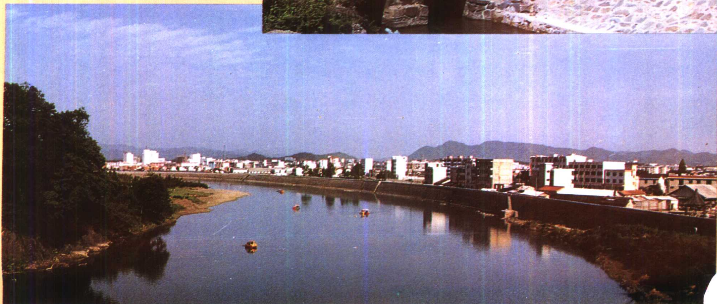
西津河防洪堤
