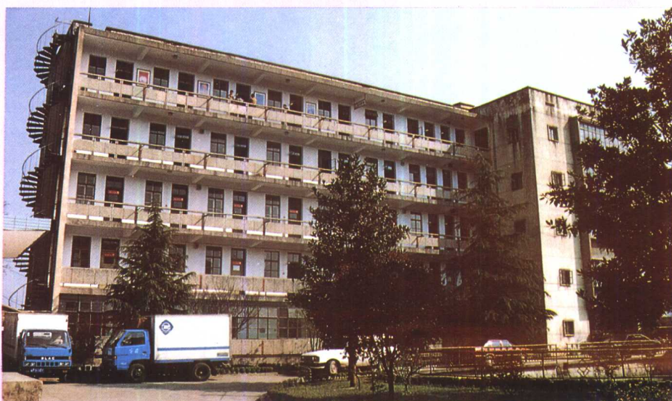
县政府机关办公楼
