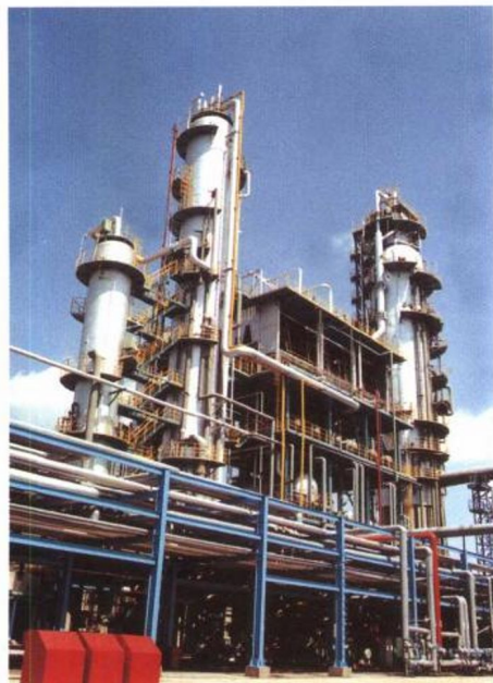
250万吨/年常减压蒸馏装置
