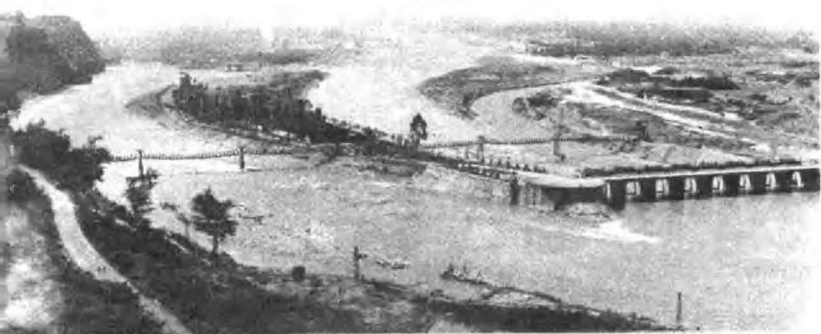
都江堰渠首工程鸟瞰
