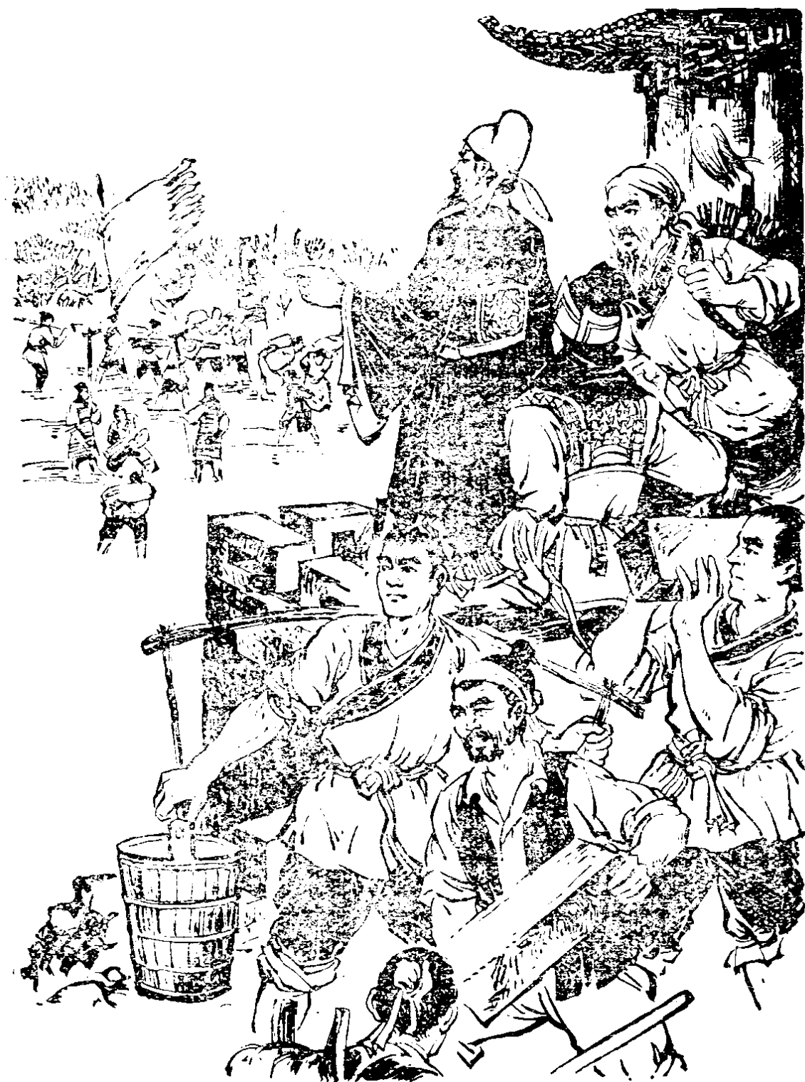
修筑城墙,挖掘城河
