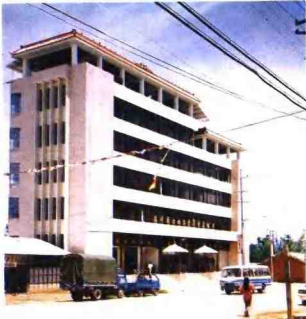
陇川县商业局——集团公司大楼
