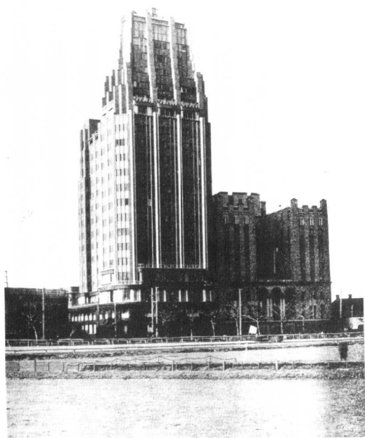
旧上海最高的建筑国际饭店
