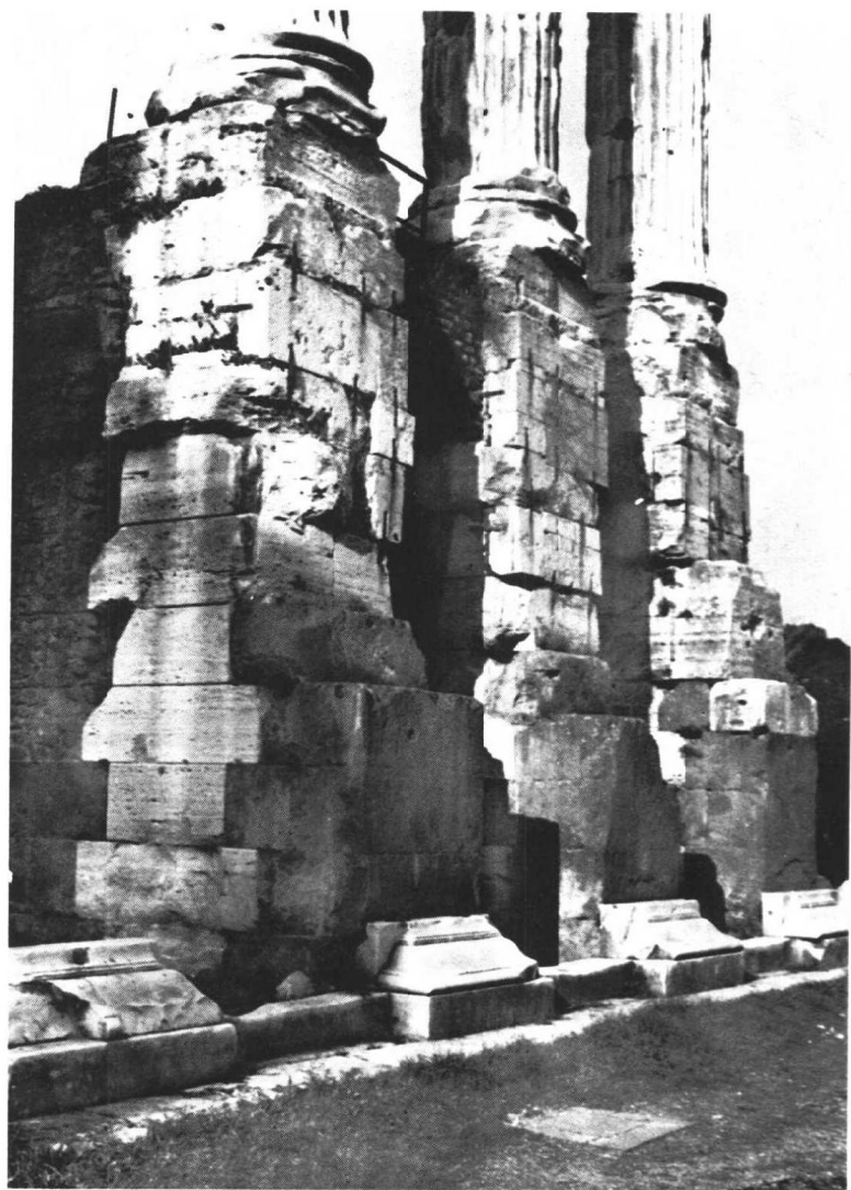
图7 罗马，罗马努姆广场的卡斯托尔和波卢克斯庙，大理石面层以及奥古斯都时期用石灰华、凝灰岩和混凝土建造的庙宇遗迹
