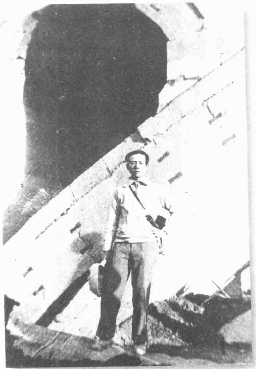
梁思成测绘河北赵县安济桥 (1933年)
