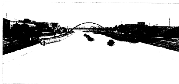
整治后的京杭大运河丹徒段一角
