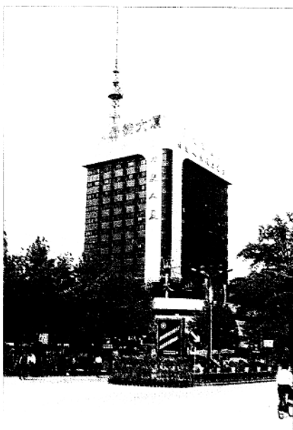
县土管局办公所在地
