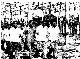
1985年，李鹏副总理视 察建设中的房山500千伏变 电站
