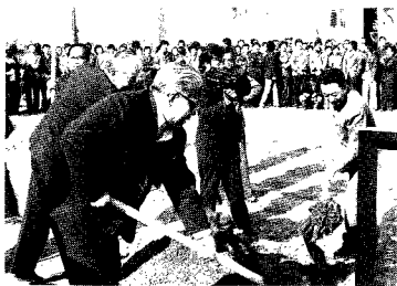
1985年10月，中共 北京市委书记李锡铭、 北京市市长陈希同为首 为石景山热电厂工地奠基
