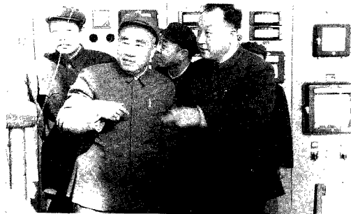
1959年11月2日，朱德委员长视察北京热电厂
