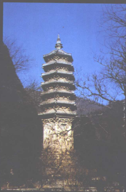
北齐善化寺元代舍利塔
